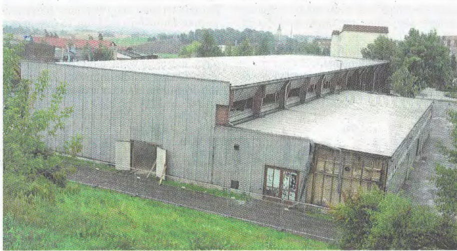
Was von der Harthaer Turnhalle übrig bleibt, wird von der Abrissfirma entsorgt beziehungsweise zur Wiederverwertung aufbereitet. DAZ-Fotos (2): Jürgen Kulschewski
