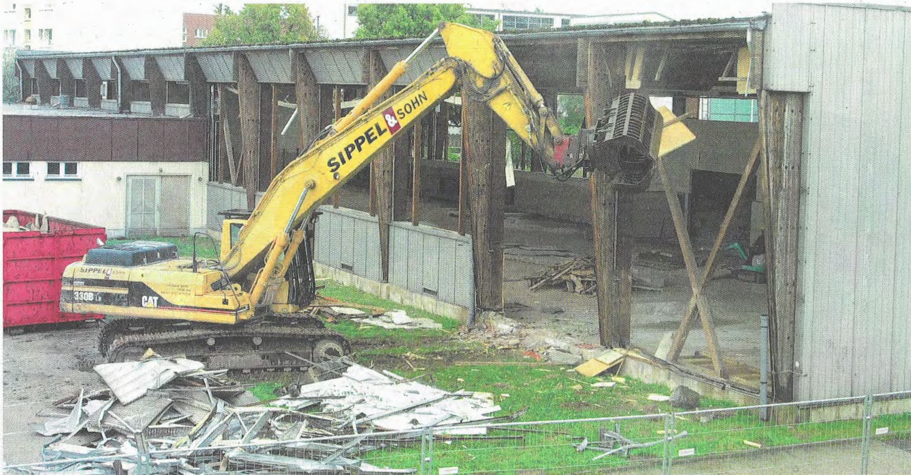
Gestern war es so weit: Der Abrissbagger riss sich die ersten großen Brocken aus der Sporthalle in Hartha Nord. Seit Monatsbeginn waren die Entkernungsarbeiten im Inneren der Halle gelaufen, wobei elektrische Anlagen, Heizung und der Fußboden sowie die Fenster ausgebaut wurden. Bis 31. August soll die Halle völlig verschwunden sein.
